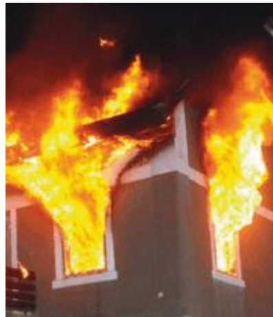
Abbildung 8 - alle Fenster sind flächig mit Flammen ausgefüllt, so dass der notwendige Sauerstoff von einer anderen Zuluftquelle kommen muss, Quelle: ecomed-Storck GmbH
