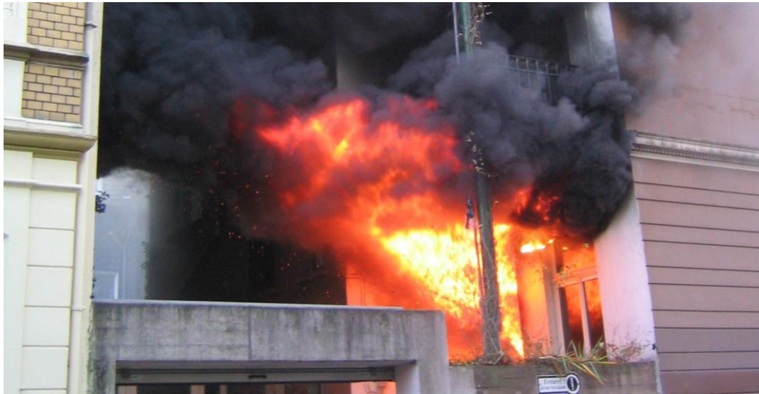
Abbildung 1 - Situation bei Eintreffen: Feuer und Rauch schlagen aus der Nutzungseinheit, Quelle Wilde, ecomed-Storck GmbH
