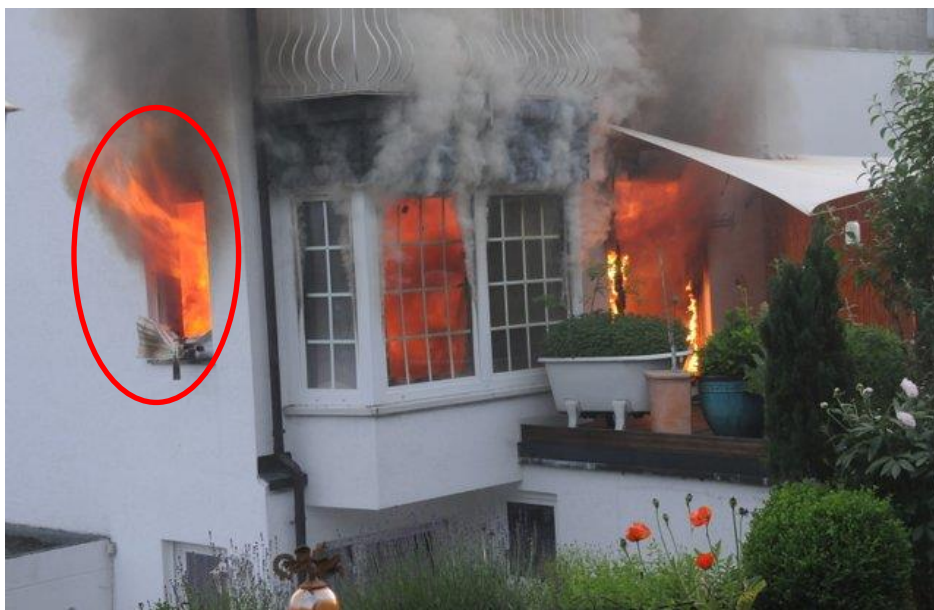
Abbildung 11 - Seitenfenster ist sowohl Abluft- (oben - Flammen) als auch Zuluftöffnung (unten), Rossbach, Wuppertal, ecomed-Storck GmbH
